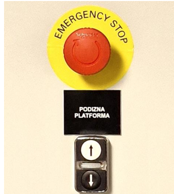
Slika 21. Tipkalo za isklup u slučaju nužde (rad autora)
