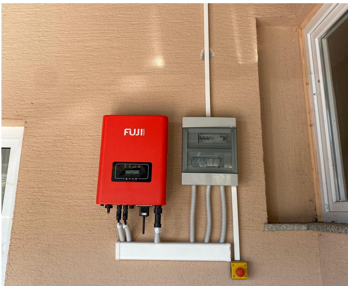
Slika 63. Primjer ugradnje jednog tipa izmjenjivača u kućanstvu [autorski rad]
